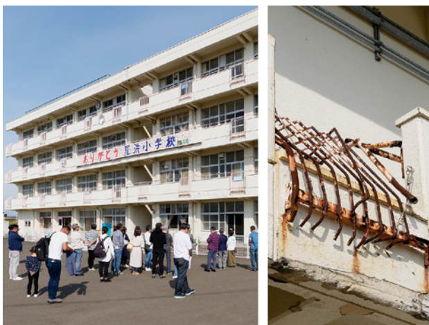
震災遺構「仙台市立荒浜小学校」
